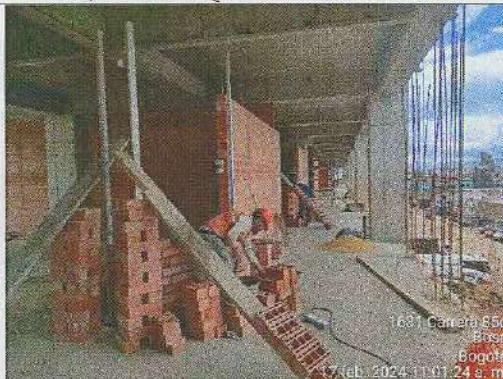
MAMPOSTERIA EN LADRILLO PUNTO FIJO NIVEL 15,60 BLOQUE 1 - 17/02/2024
