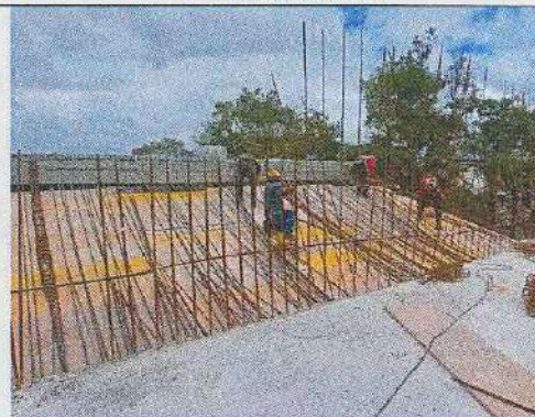
FORMALETA VIGA CORONA CUBIERTA BLOQUE 3 - 16/02/2024
