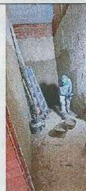
EXCAVACION MANUAL PARA REPARACION DE ZAPATAS BLOQUE 3 - 14/02/2024
