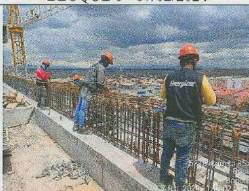
ARMADO DE ACERO PARA ESCALERA NIVEL + 6.10 AL NIVEL + 8.00 BLOQUE 7 - 08/02/2024
