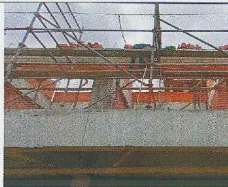
ARMADO DE ACERO E INSTALACION DE CASETON PARA PLACA NIVEL 19,40 BLOQUE 2 - 15/02/2024
