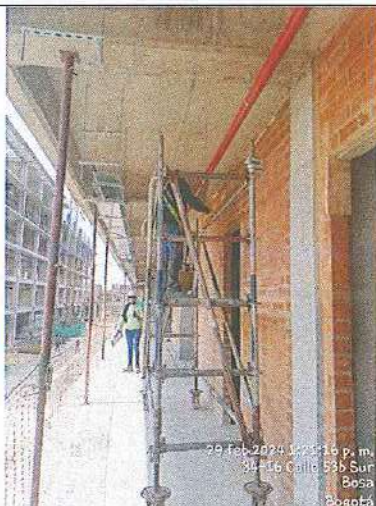
INSTALACION DE TUBERIA RCI NIVEL + 4,20 BLOQUE 6 - 29/02/2024
