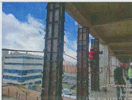
ARMADO DE ACERO PARA MURO PERIMETRAL CUBIERTA NIVEL + 23.20 BLOQUE 1 - 07/02/2024
