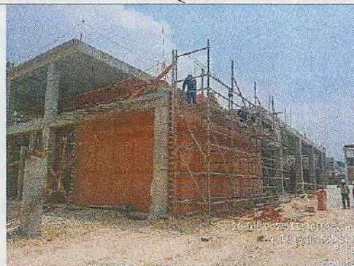
INSTALACION DE MALLA PARA PLACA DINTEL FACHADA BLOQUE 5 - 26/02/2024
