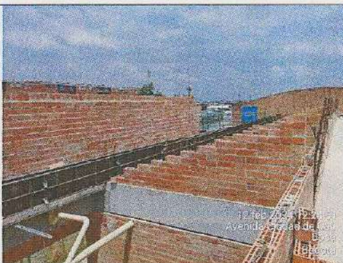
ARMADO DE ACERO Y ENCOFRADO MURO PERIMETRAL CUBIERTA NIVEL + 23,20 BLOQUE 1 - 12/02/2024
