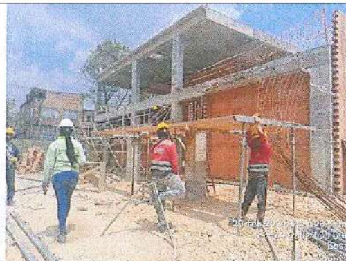
ARMADO DE ACERO Y ENCOFRADO DE VIGA DE CIMENTACION BLOQUE 5 - 29/02/2024
