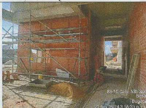
ENCOFRADO DE VIGA CORONA CUBIERTA BLOQUE 3 - 21/02/2024
