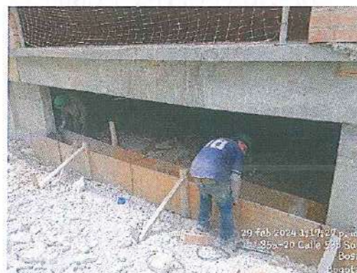
ARMADO DE ACERO Y ENCOFRADO DE VIGA DE CIMENTACION BLOQUE 5 - 29/02/2024
