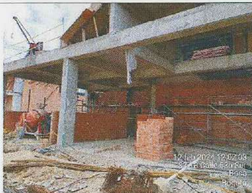
ENCOFRADO VIGA CORONA CUBIERTA BLOQUE 3 - 12/02/2024
