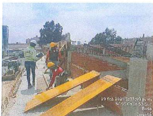
ARMADO DE ACERO CORTASOLES NIVEL + 11,80 BLOQUE 2 - 29/02/2024
