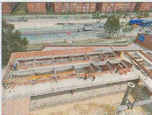
MAMPOSTERIA EN LADRILLO PUNTO FIJO NIVEL + 4,20 BLOQUE 2 - 27/02/2024
