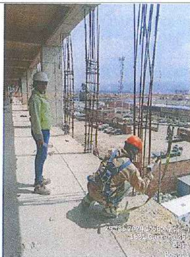
INSTALACION DE TENSORES NIVEL 0,00 BLOQUE 1 - 29/02/2024
