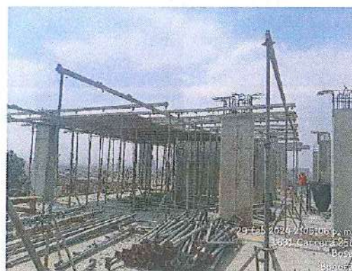
INSTALACION DE PISO VIBROPRESADO NIVEL 0,00 BLOQUE 1 - 29/02/2024
