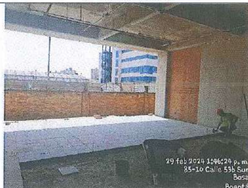
INSTALACION DE PISO VIBROPRESADO NIVEL 0,00 BLOQUE 1 - 29/02/2024
